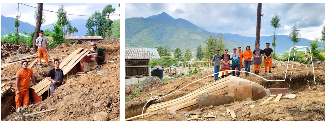
ภาพที่ 35-36 : โครงไม้สำหรับเป็นโครงเพื่อรองรับการพอกดินเพื่อใช้ทำเป็นหลังคาเตา พื้นที่สร้างเตาอยู่ที่ DE-SUUNG SKILLING PROGRAMME Taba Center, เมือง Thimphu
