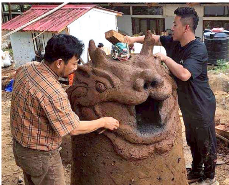
ภาพที่ 43-44 : ตัวเตาเมื่อทำการพอกดินสำเร็จ บริเวณปล่องเตาได้ออกแบบให้เป็นรูปมังกรตามรูปแบบของศิลปะงานแกะสลักไม้ของภูฏาน
