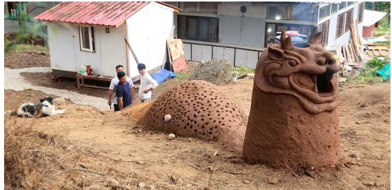
ภาพที่ 43-44 : ตัวเตาเมื่อทำการพอกดินสำเร็จ บริเวณปล่องเตาได้ออกแบบให้เป็นรูปมังกรตามรูปแบบของศิลปะงานแกะสลักไม้ของภูฏาน
