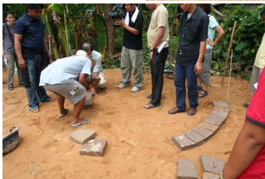
รูปที่ 13.1 ทีมอาจารย์สอนชาวบ้านก่อสร้างเตาเผาเครื่องปั้นดินเผาใช้ฟืนเป็นเชื้อเพลิง
