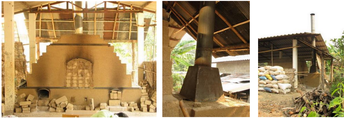
รูปที่ 13.3 เตาเผาที่ได้ออกแบบและร่วมกันก่อสร้างกับชาวบ้าน
