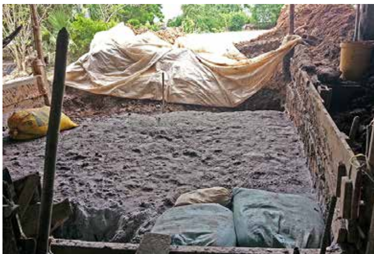
รูปที่ 3 บ่อที่ใช้สำหรับการหมักดินตำบลมหาพราหมณ์ อำเภอบางบาล จังหวัดพระนครศรีอยุธยา
