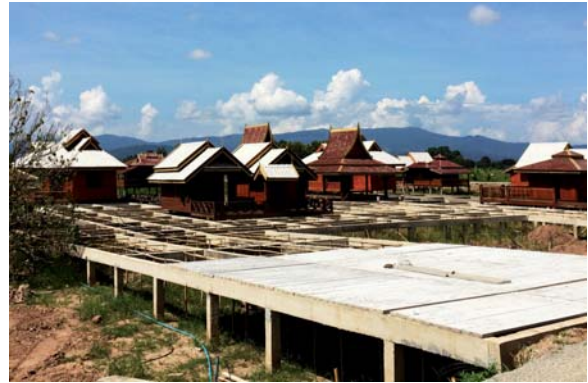
การก่อสร้าง พื้นที่แสดงสินค้า OTOP ภายในโครงการนาคาชนคร
