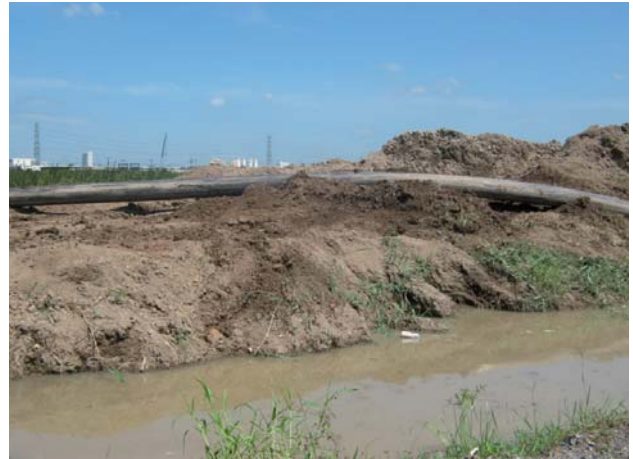
รูปที่ 2 บ่อตากตะกอน (Polder) ที่โรงผลิตน้ำประปาบางเขน
