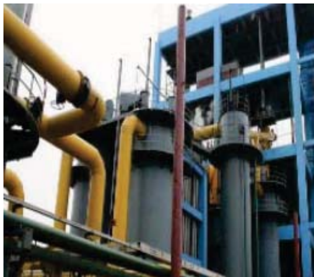
การใช้ถ่านหินแทนก๊าซ NG หรือ LPG โดย Coal Gasification System
