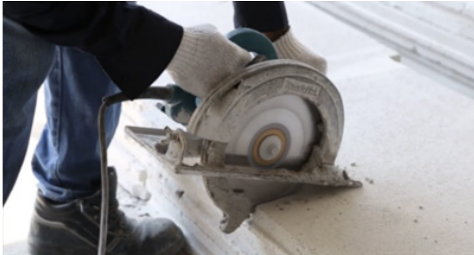
รูปที่ 3 การตัดแผ่นปะการัง
