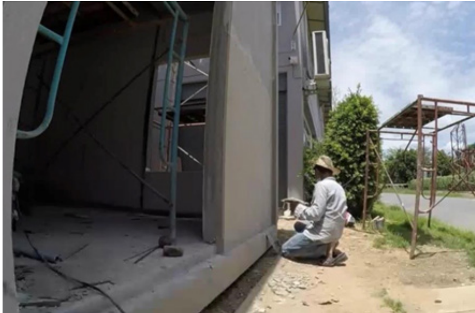
รูปที่ 8 การฉาบผิวบาง (skim coat) บนแผ่นปะการัง
