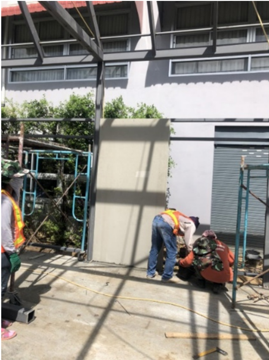
รูปที่ 5 การยกติดตั้งแผ่นปะการัง
