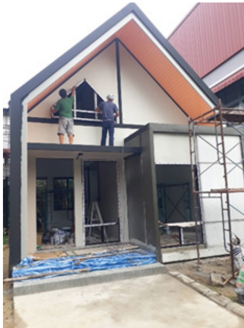
รูปที่ 10 การติดตั้งประตู-หน้าต่าง และเก็บรายละเอียด
