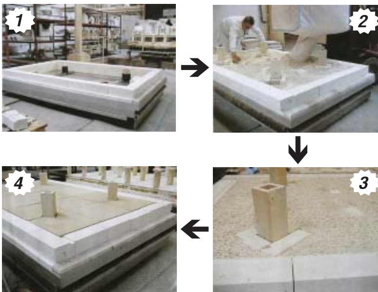
รูปที่ 5-8 : แสดงขั้นตอนและวิธีการติดตั้ง Ultralite ลงในรถเตา
